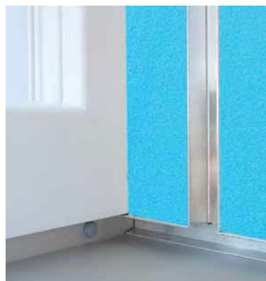
Detail ostění se sendvičovou deskou
