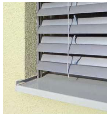
Detail ostění se zabudovanou žaluzií
